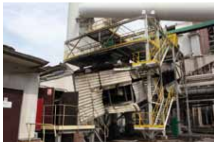
↑ Galerie nawęglania – kryty most nawęglania nr 1 i 2 do bloków energetycznych nr 1-4
