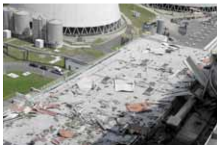
↑ Zniszczone elementy ścian zewnętrznych po wybuchu
