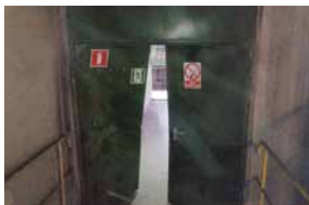
↑ Drzwi przeciwpożarowe oddzielające kotłownię od hali maszynowni zniszczone przez falę uderzeniową
